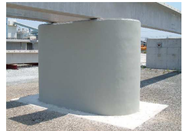
仕上げ材塗布
