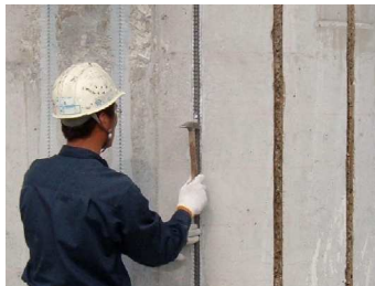
補強主筋定着
