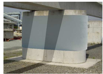
仕上げ材塗布
