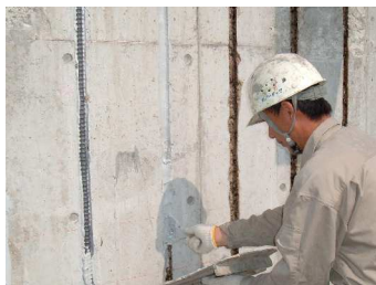
補強主筋定着
